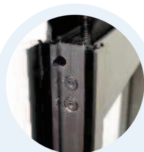
Λεπτομέρεια σύνθεσης προφίλ Detail from profiles connection
